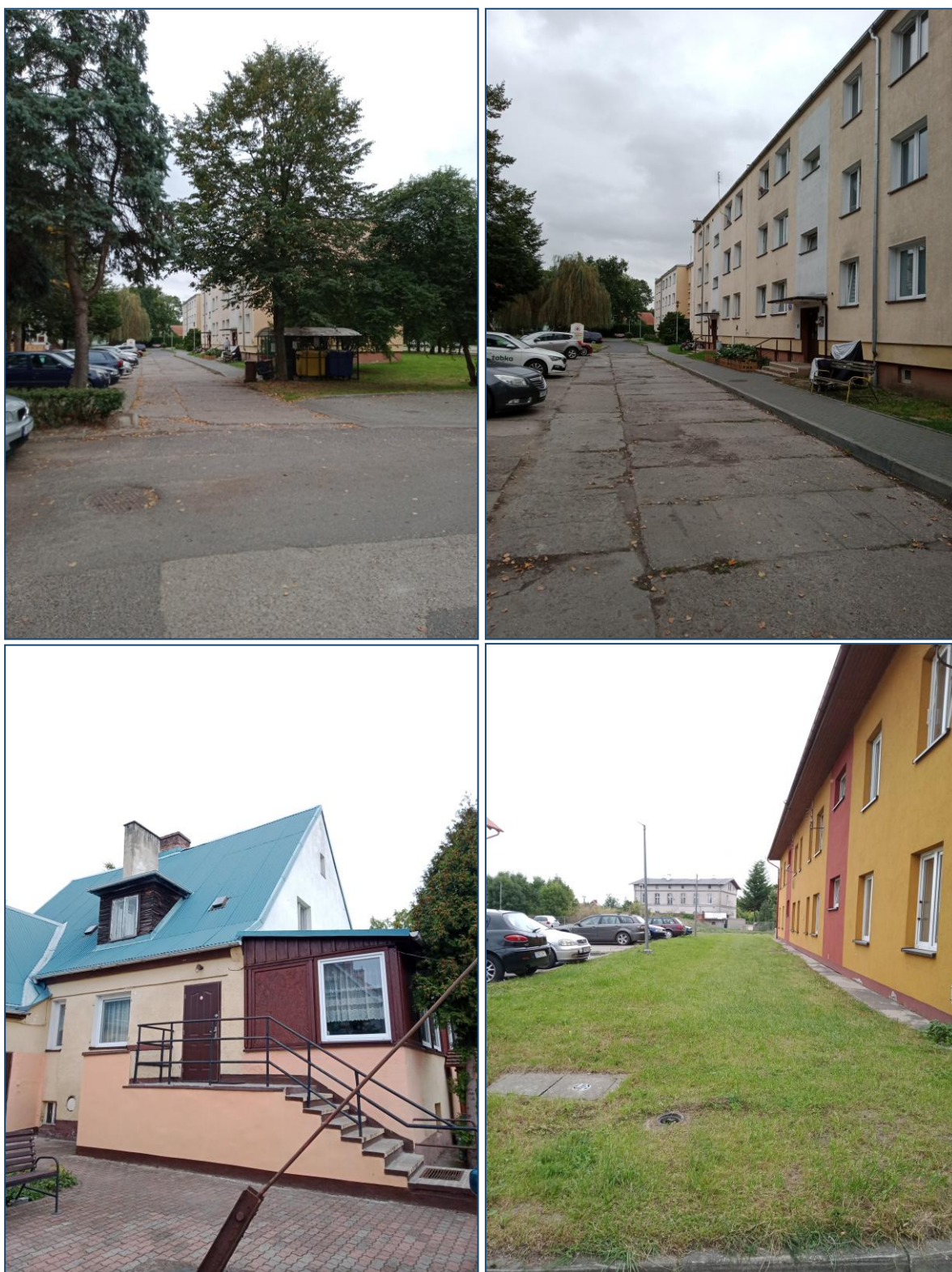
Ryc. 17 Stan sfery przestrzenno-funkcjonalnej w granicach obszaru rewitalizacji: zdjęcia górne – os. Morska; dolne lewe – budynek WTZ, dolne prawe – ul. Gen. Tadeusza Kościuszki 4A
