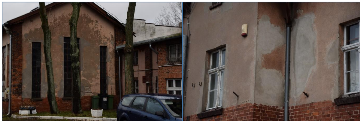
Ryc. 23 Budynek dworca kolejowego w Nowym Dworze Gdańskim Źródło: materiały z wizji lokalnej przeprowadzonej w dniu 2.10.2023 r.
