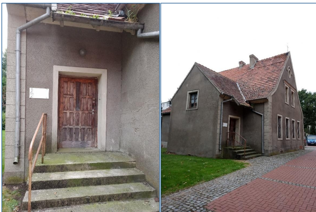
Ryc. 22 Budynek parafialny przy ul. Michała Drzymały 3
