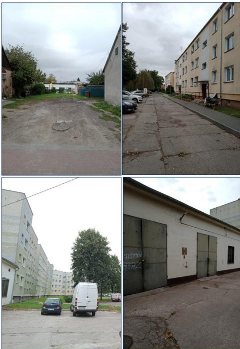
Ryc. 19 Degradacja infrastruktury komunikacyjnej, lewe górne zdjęcie: ul. Generała Tadeusza Kościuszki, pozostałe zdjęcia: osiedle przy ul. Warszawskiej i Morskiej
